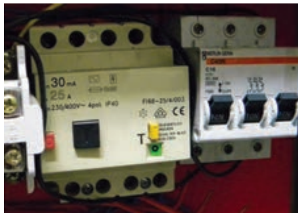
شکل ۱-۵- فیوز حفاظتی نصب شده در کارگاه
